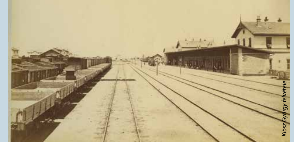
Hatvan állomás felvételi épülete
